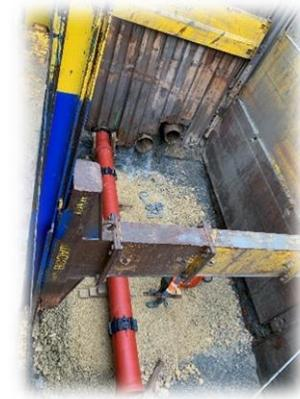
*Réalisation du fonçage sous les voies SNCF*
