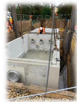
*Mise en place du déversoir d'orage et du poste de refoulement rue des Mines à Jarny*
