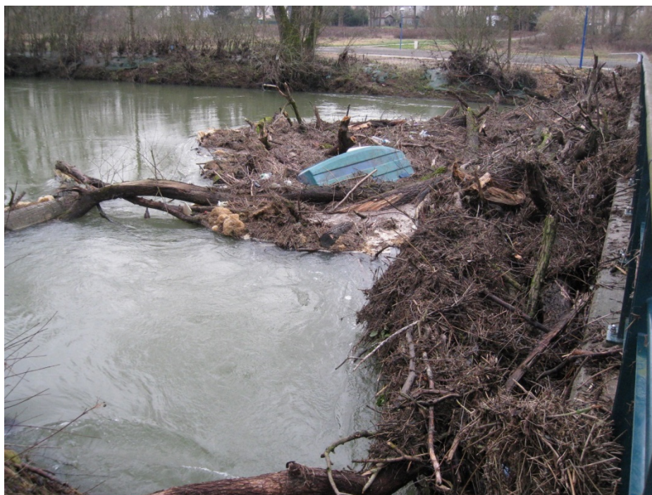
Embâcle majeure créée en janvier 2018 du fait des piles et du parapet de la passerelle d'Homécourt.
