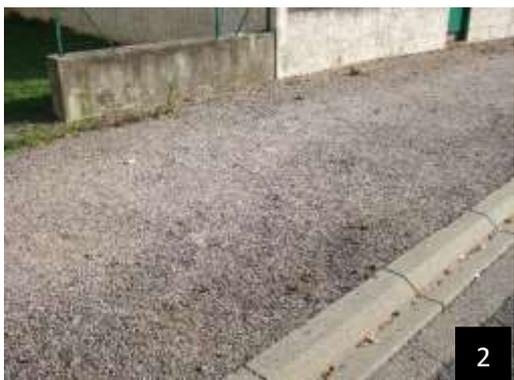
Le trottoir est actuellement recouvert d'une couche de gravillon, surface instable et inégale, pouvant provoquer des chutes.
